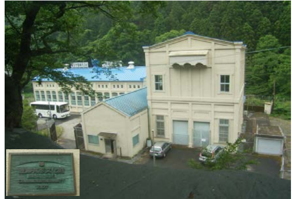
重要文化財に指定されている石岡第一発電所 (明治44年竣工)
