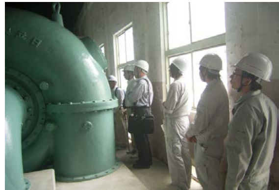
中里発電所から移設された発電機
