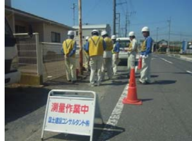
【現場での作業前打ち合わせ】
