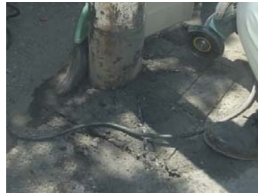
【カットラインを入れたアスファルト】
